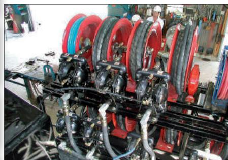
1" UL zertifizierte Kraftstoffpumpen installiert zur Kerosinbefüllung.
